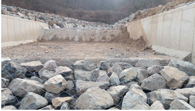
그림 4> 외송천에서 상류를 바라보고 찍은 모습. 정면에 낙차공은 사람이 오르기에 높은 높이. 아래쪽으로 돌을 묶은 와이어가 보임.
