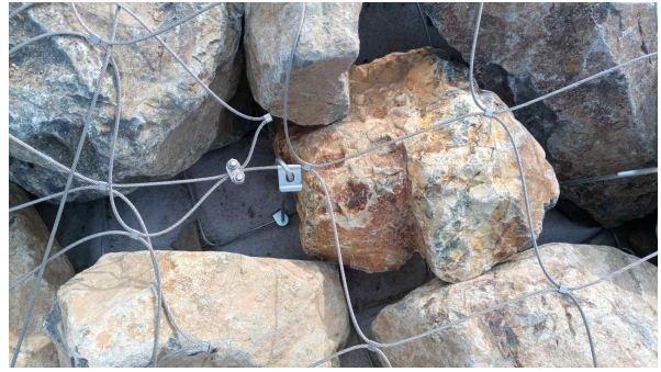
그림 5> 돌을 묶은 와이어를 가까이 찍은 사진. 수평 방향만이 아니라 수직으로 와이어끼리 묶어 고정된 것도 확인됨. 그림4의 상류부분
