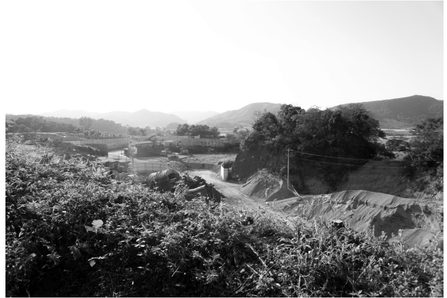
강정리 마을회관에서 300m도 안 떨어진 건설폐기물처리장(사진=신은미).
