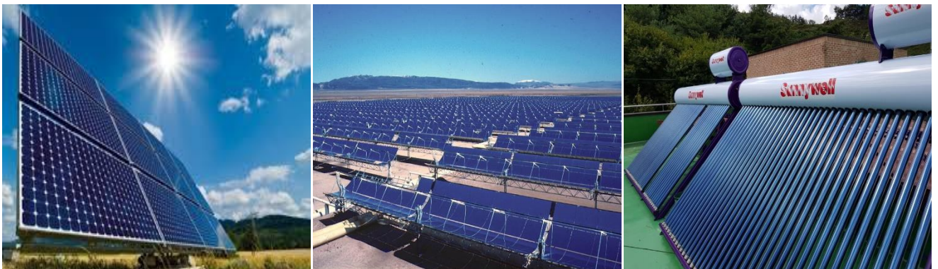
▲ 왼쪽부터 '태양광 발전 - 태양열 발전 - 태양열 온수' 설비. 태양열 발전은 태양광과 달리 열을 모으기 위해(집열) U자 모양으로 설계되어 있고, 태양열 온수 설비는 위에 축열조라 부르는 탱크가 보입니다.
