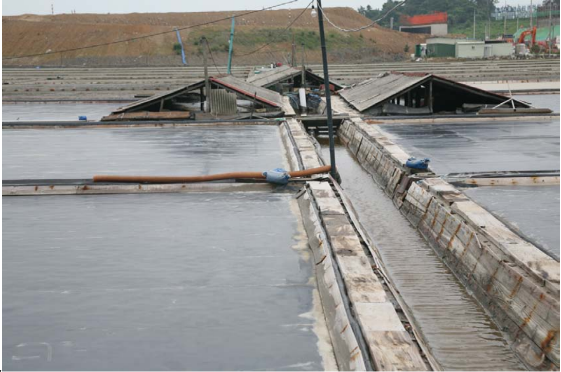
<사진, 전남신안의 한 염전, 지붕이 낮은 해주창고가 염전들 사이에 위치해 있다. 해주건물의 특성상 바람과 강우로 인해 지붕슬레이트의 석면이 염전을 오염시킬 가능성이 매우 커 보인다.>
