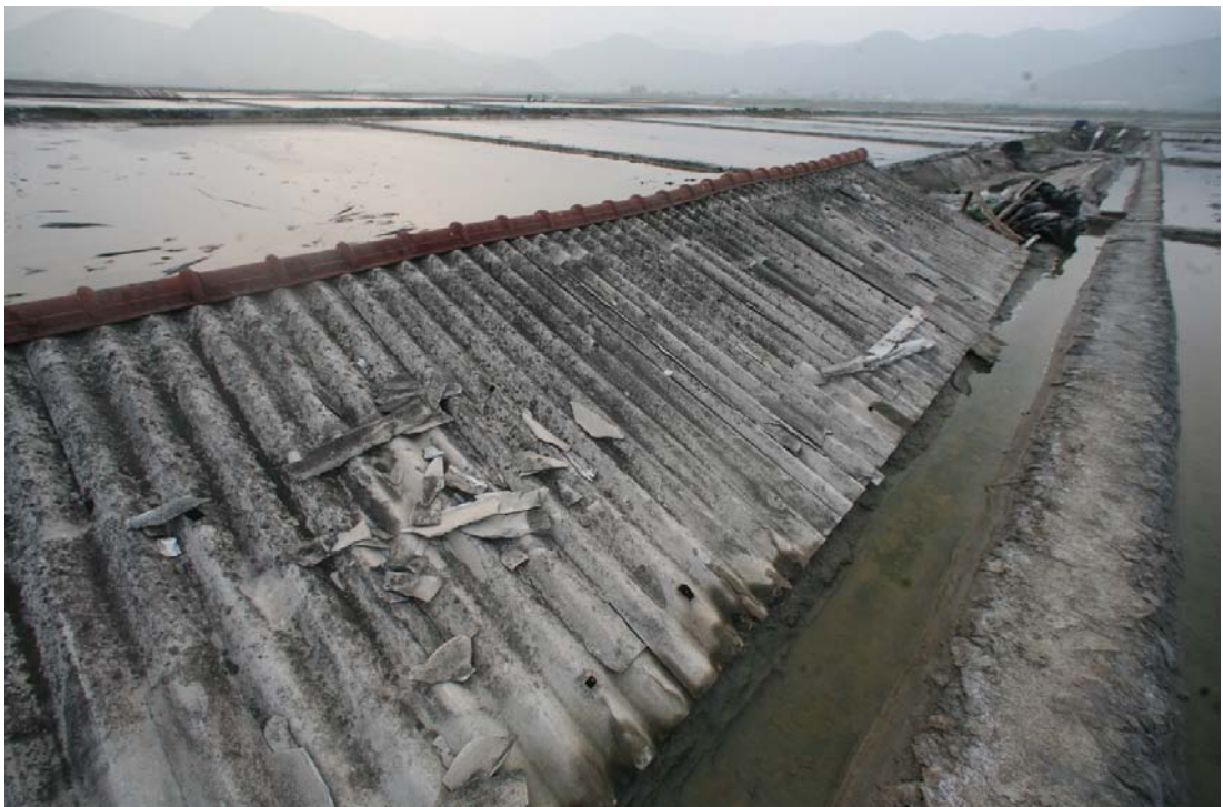
<사진, 전북부안의 한 염전, 낡고 깨진 석면슬레이트 지붕으로 된 해주창고의 모습>
