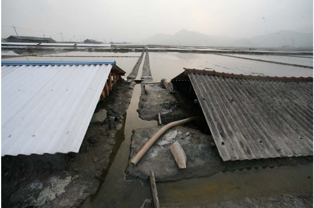
<사진, 전북부안의 한 염전, 이곳은 비석면 자재로 해주창고를 교체하고 있으나 깨진 석면슬레이트 폐기물을 제대로 처리하지 않고 있다>
