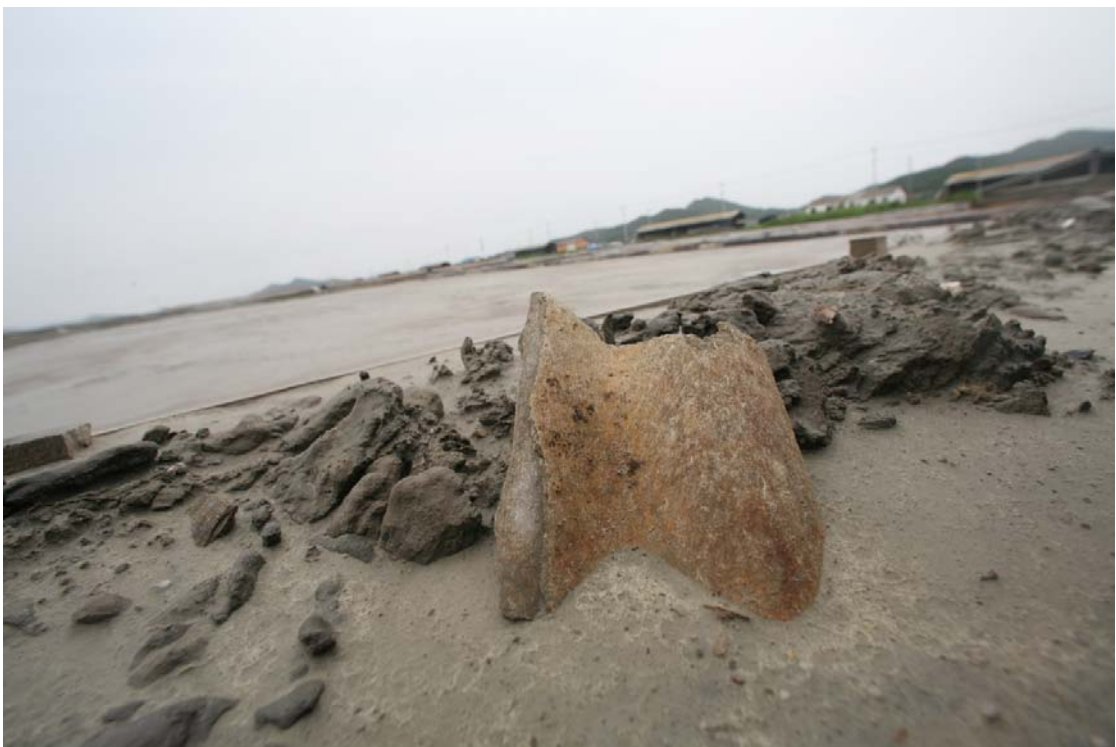
<사진, 전남신안의 한 염전 한가운데 위치한 해주창고 주변에 깨진 석면슬레이트 조각이 여기저기 널려있다.>
