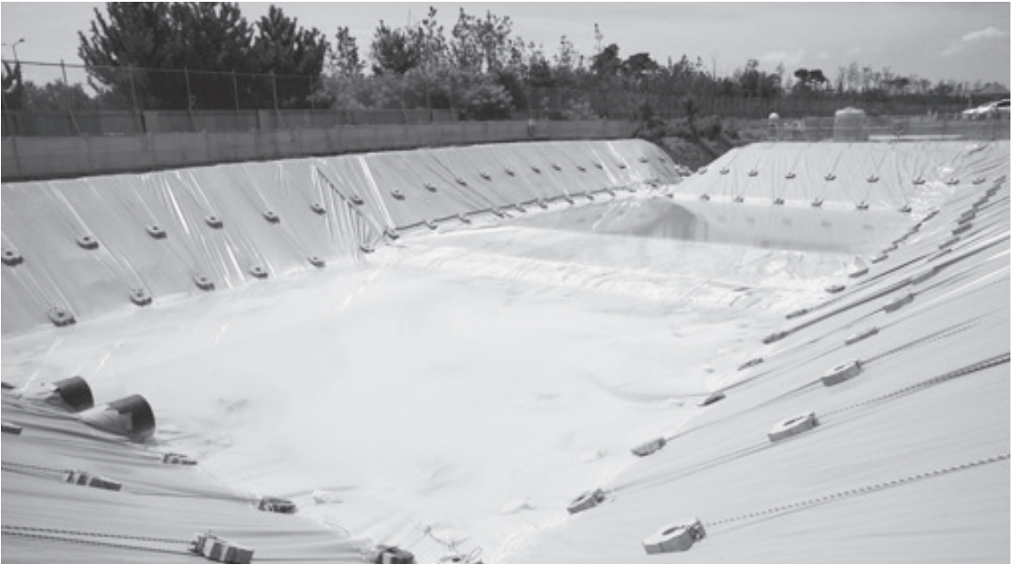
송산2일반산업단지 현대제철 슬래그 성토장에 설치된 침사지 모습.
