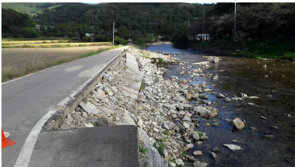
하천 제방변 호안시설 홍수로 유실 훼손('20) 제2사담교 아래 좌(우)안
