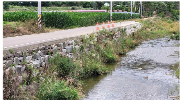
하천 제방변 호안시설 홍수로 유실 보수 후('22) 제2사담교 아래 좌(우)안
