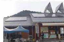
지역진흥시설 (1시설, 발전출력 18kW)
