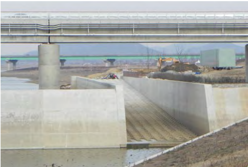
▲ 기능을 못하고 있는 승촌보 어도. 보 상류에서 보면 어도머리가 허공에 떠있다. 현재와 향후 홍수기에 수위를 낮추면 어도가 기능을 못한다. 보를 만들어 생태계를 단절시키고 있는 것이다.
