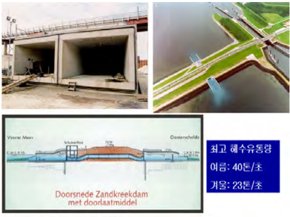
그림 2 네덜란드 휘어스호의 잔트크리크담에 설치한 해수유통을 위한 터널로서 5.5x3m 크기로 여름철에는 40톤/초, 겨울철에는 23톤/초의 물을 유통시킨다. 잔트크리크호의 규모는 1억 1천만톤으로 영산호나 금호호의 규모에 비해 작다.
