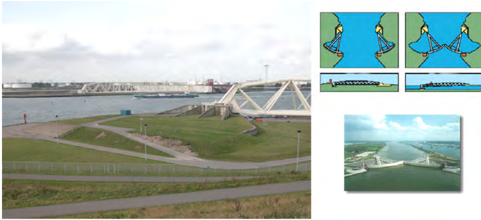
그림 4 1997년에 완성된 네덜란드 마에스란트케링의 모습 부채모양의 움직이는 댐이 평시에는 해안에 붙어 있다가 해일 경보시에 닫히도록 설계되어 있다.
