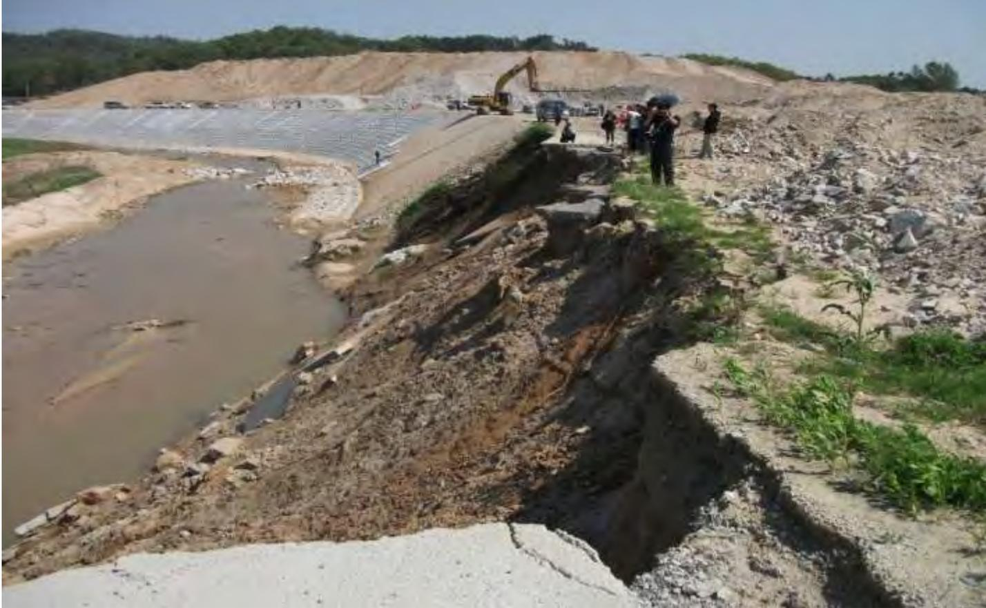
역행침식으로 콘크리트 제방도로 약 **20m** 무너짐, 제방 공사중
