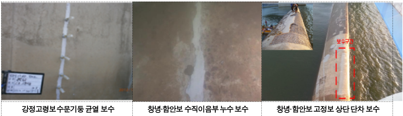
[그림 20] 균열·누수 및 손상부위 보수 전경
